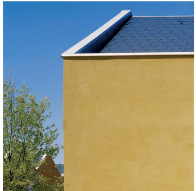
Détail du décaissé de toiture pour marquer les frontons
