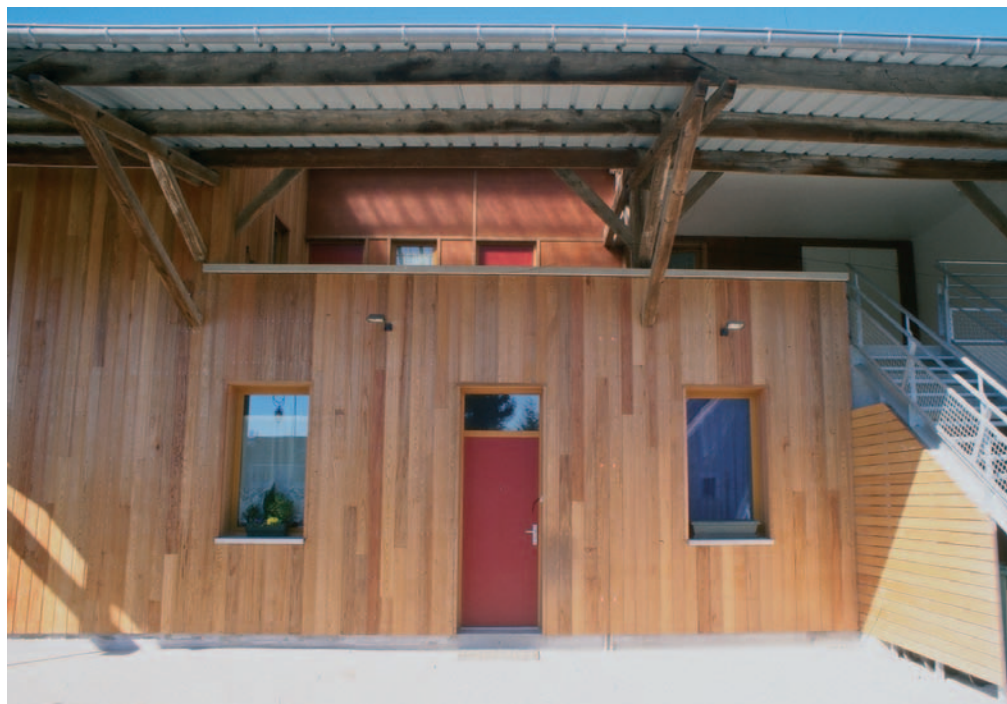
Vue extérieure : identification des logements © Heidi Meister
