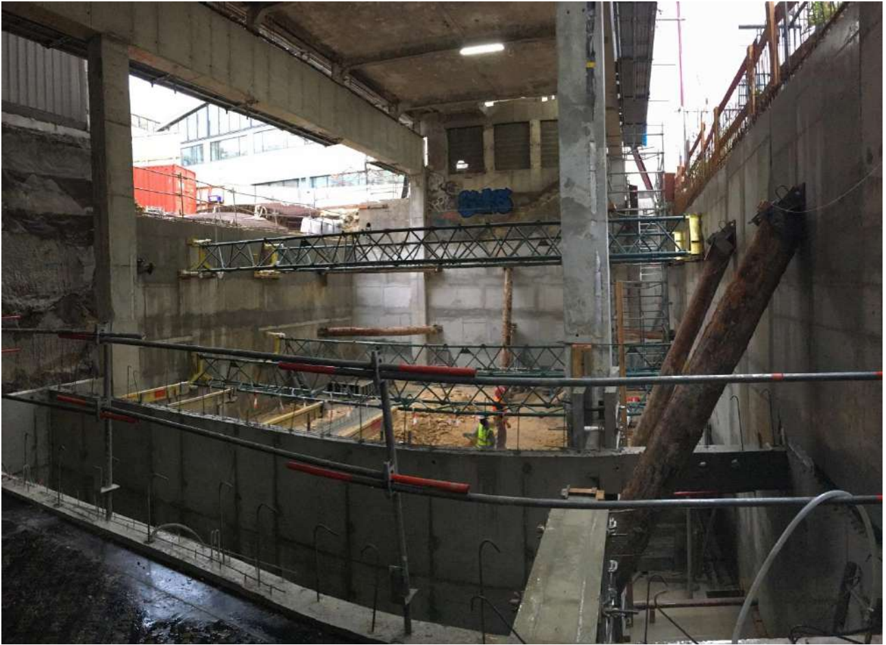
PHASE 4 / EXCAVATION DU SOUS-SOL ET BUTONNAGE
