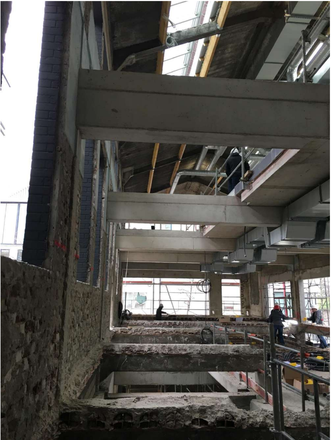
PHASE 5 / COULAGE DES POUTRES ET PLANCHERS NEUFS
