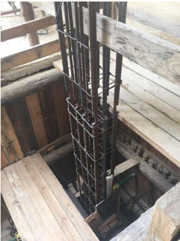
PHASE 2 / CREATION DES PUIITS ET DES POTEAUX JUSQU'A -6M
