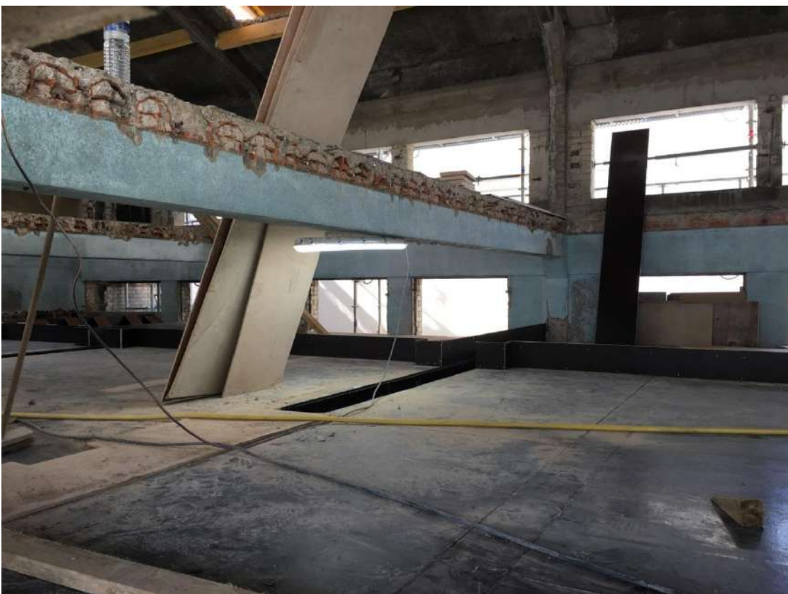
PHASE 5 / COULAGE DES POUTRES ET PLANCHERS NEUFS
