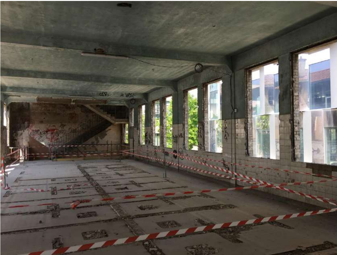
PHASE 1 / CURAGE INTERIEUR
