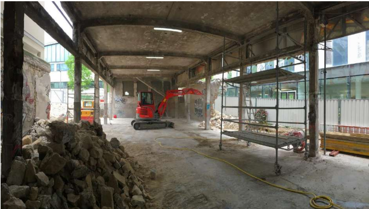
PHASE 1 / CURAGE INTERIEUR
