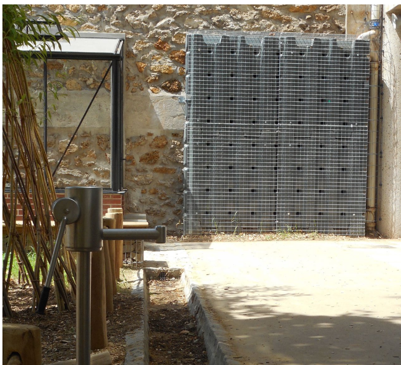
A l'école Emeriau, le réservoir d'eau de pluie est relié au lit d'une « rivière » en galets et enrochements. À l'école Kuss, le réservoir est relié à une rigole bordée de pavés. Au premier plan, une fontaine à boire, dont l'eau en surplus part dans la rigole.
