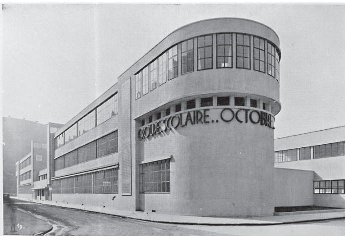
GRUPE SCOLAIRE D'ALFORTVILLE : FAÇADE
