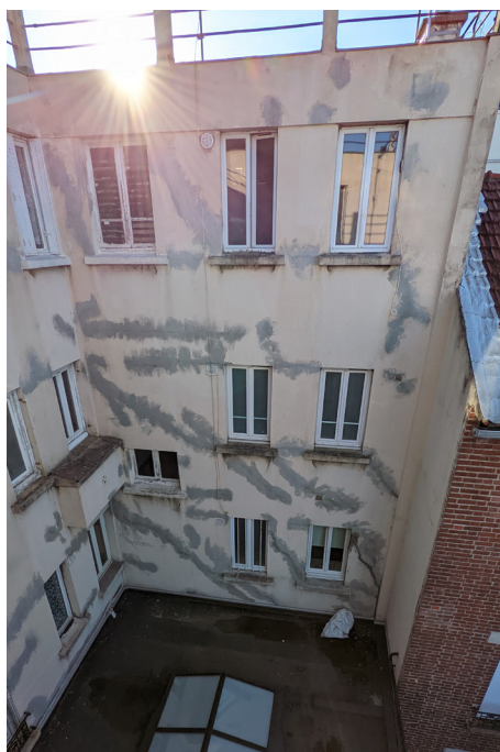
Le bâtiment avant travaux : façades arrière © RéALisa
