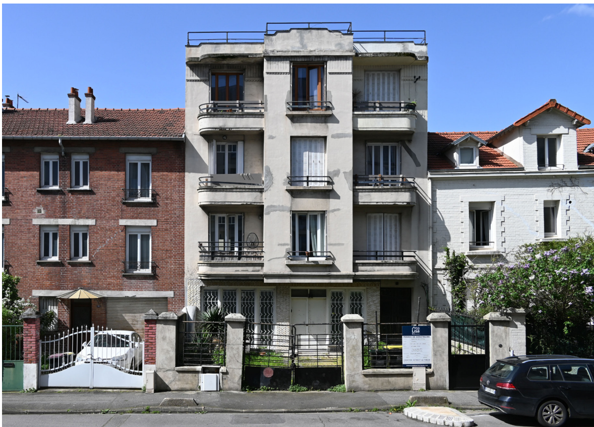
Le bâtiment avant travaux : façade sur rue © CAUE 94
