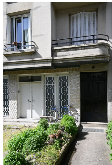
Le bâtiment avant travaux : détails de façade sur rue © CAUE 94
