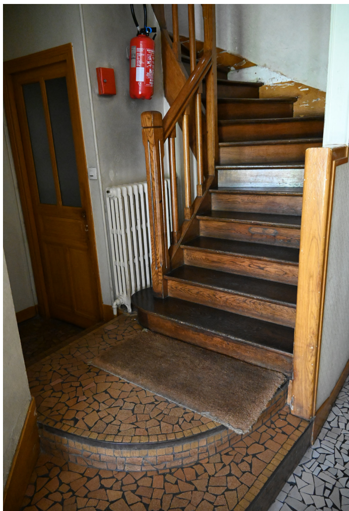
La cage d'escalier 1 avant travaux © CAUE 94
