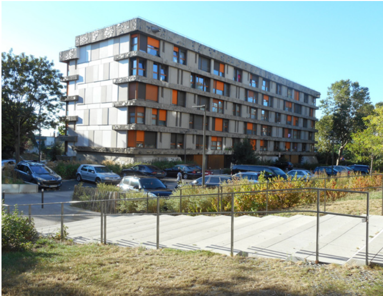
Emmarchement permettant la montée d'un camion citerne avec rampes démontables
