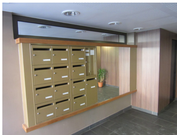
Caisiers boîtes aux lettres, second jour en partie haute et miroir
