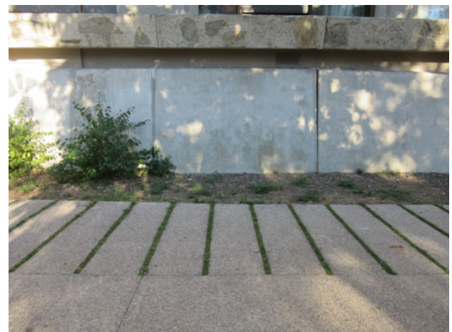
Espacement entre dalles ménagés pour atténuer les bruits de roulement
