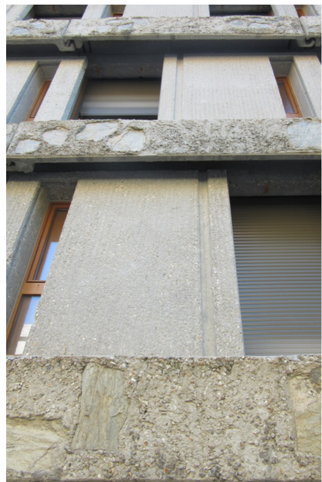
Façade rénovée avec intégration des menuiseries bois et des volets roulants, sablage des trumeaux et purge des schistes
