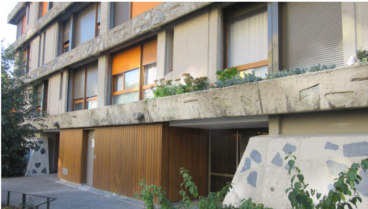
Hall d'entrée réhabilité des bâtiments C et I : bardage bois, jardinière rénover et ardoises en soubassement re-cimentées
