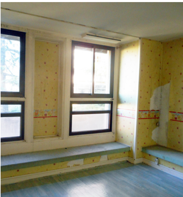
Banquette dans les chambres, avant réhabilitation
