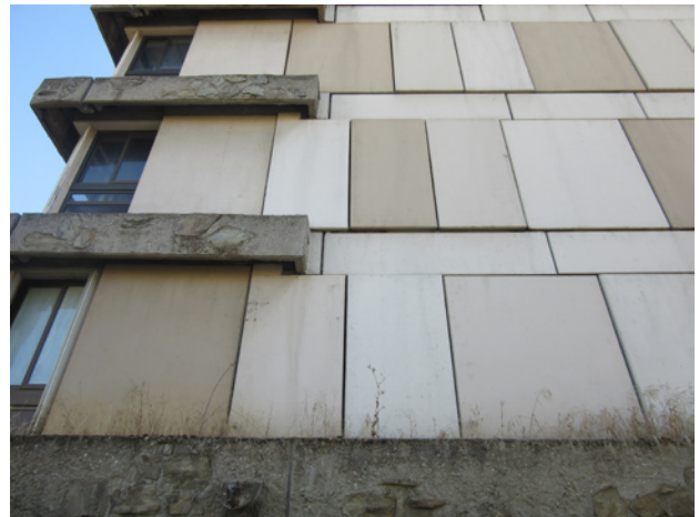
Pignon avant travaux de ravalement
