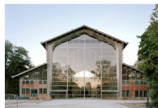
HANGAR Y MEUDON (92)
