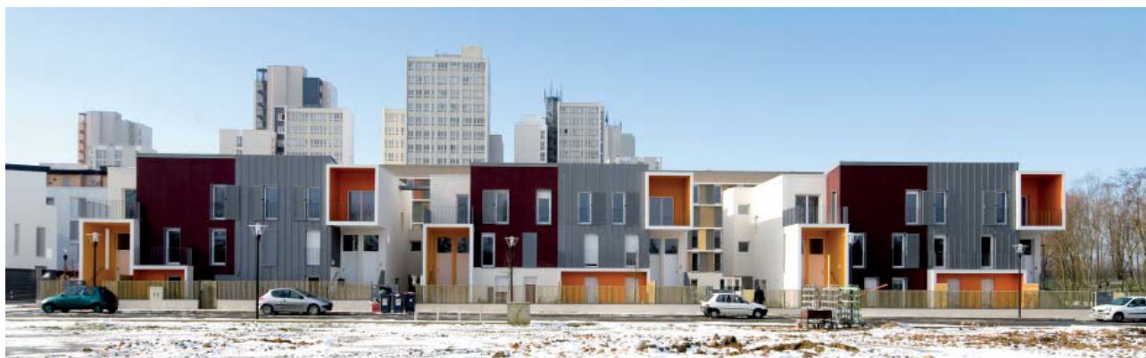
Façades des maisons en bande sur la rue de Chablis.
