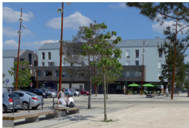
Prolongements extérieurs (sur la place) : balcons filants
