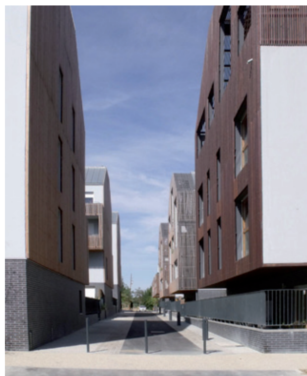
Traitement des rez-de-chaussée au niveau de la venelle piétonne
