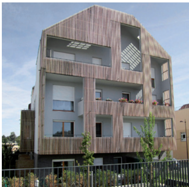
Pignon Sud (sur canal) : prolongements extérieurs en double hauteur
