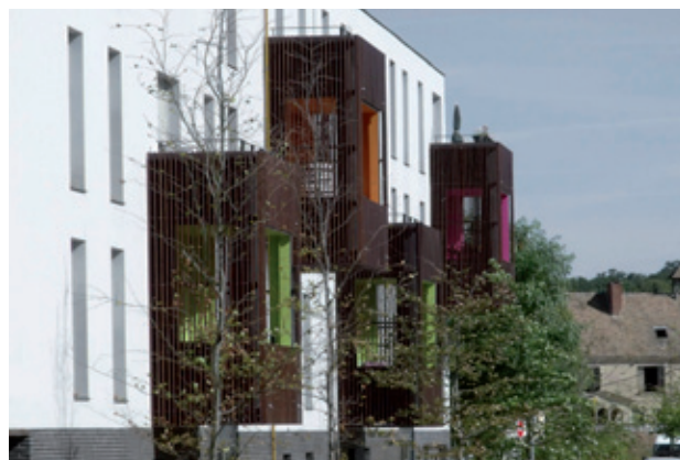
Loggias des logements sociaux
